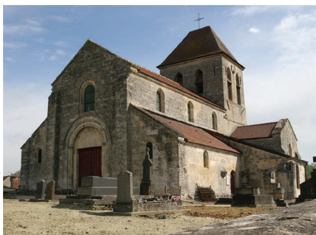
L'église Saint-Pierre-aux-Liens à Chivy-lès-Étouvelles.
