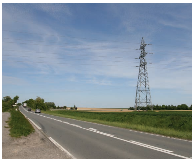
Ligne à haute tension au nord de Chambry.
