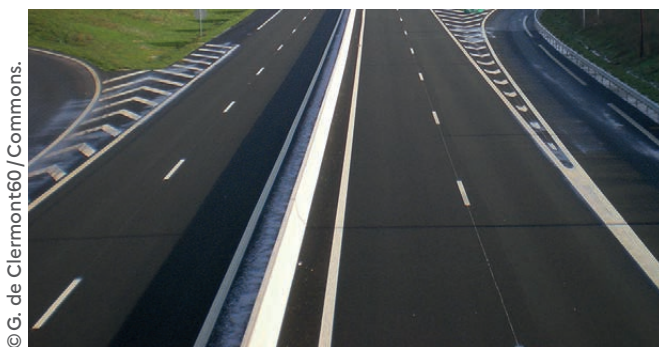
Exemple de terre-plein central.
