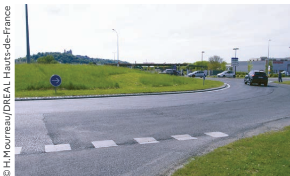
Giratoire de l'Escargot (carrefour RN2/RD1044/RD181).
