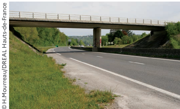
La RN2 déjà aménagée à 2x2 voies, au niveau de l'échangeur de Chivy-lès-Étouvelles.
